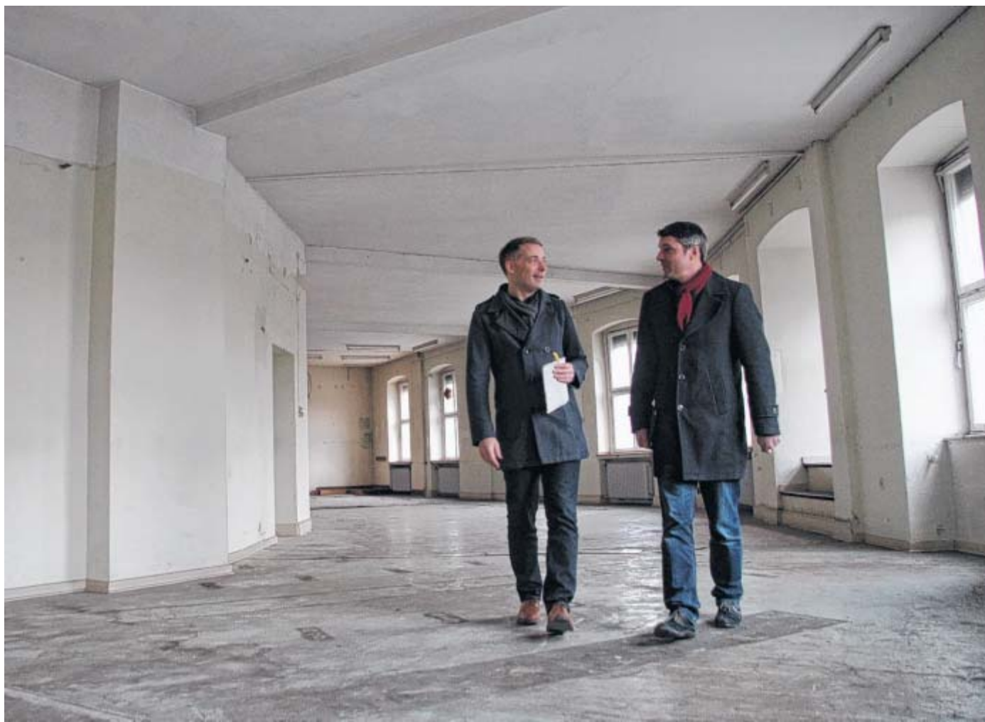
Hier ist noch einiges zu tun: Thorsten Sagner (rechts) und Tobias Heinze sehen sich im Obergeschoss des alten Postgebäudes um. Nach dem Umbau soll hier ihre Werbeagentur einziehen.
